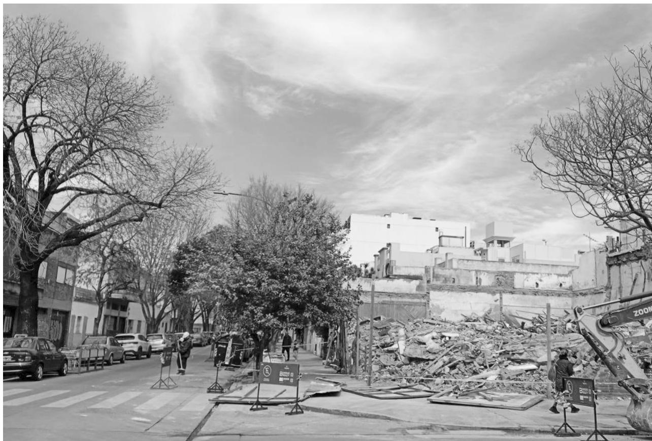
Charlone y 14 de Julio, frente a la plaza 25 de Agosto de Villa Ortúzar, a muy pocas cuadras de Colegiales. En el barrio vecino también se están llevando a cabo demoliciones como paso previo a la construcción de edificios.
