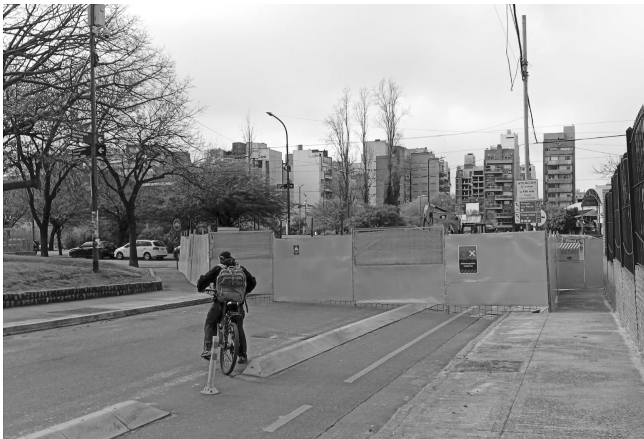
Las obras en lo que será la futura plaza ubicada junto al Mercado de las Pulgas y sus consecuencias en la circulación vehicular de Colegiales. Primero cortaron la cuadra de Concepción Arenal entre Álvarez Thomas y Martínez. Luego, como se ve en la foto, también se interrumpió el paso de autos en Martínez entre Santos Dumont y Concepción Arenal, y Concepción Arenal entre Martínez y Conde.
