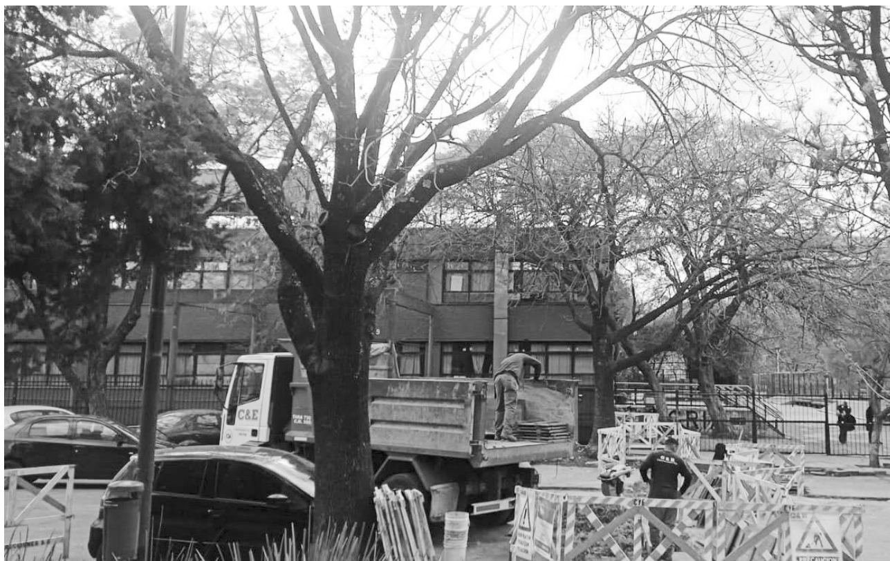
Conde entre Santos Dumont y Concepción Arenal, en unos laterales de Plaza Mafalda y a pocos metros de la escuela Scalabrini Ortiz y el Polideportivo Colegiales. Por unos días el tránsito vehicular estuvo cortado en esta cuadra por obras de Aysa.
