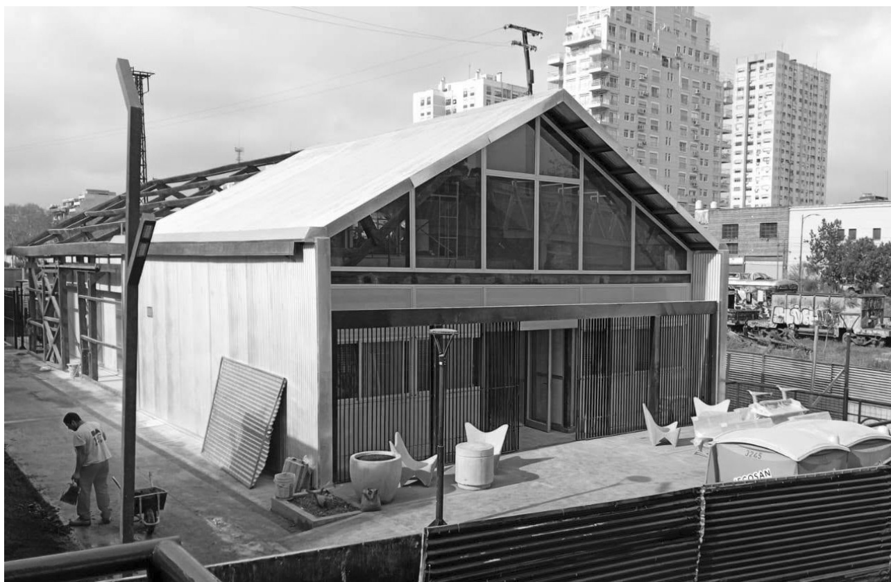
Sigue la construcción del futuro Centro de Salud municipal de Colegiales (será el único CeSAC en la totalidad de la Comuna 13). La imagen es de fines de julio. Está ubicado en el Parque Ferroviario, cerca de la esquina de Moldes y Zabala.
