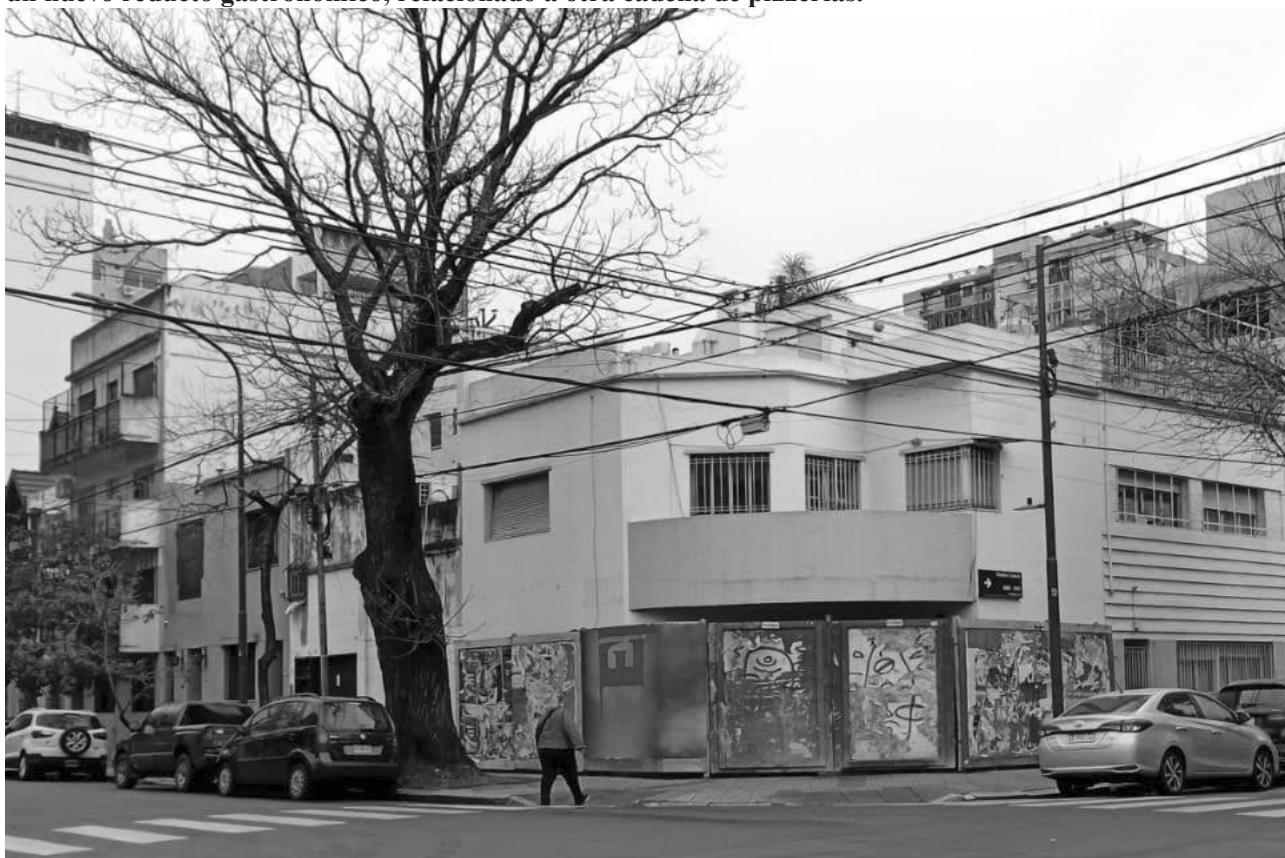
Esta vivienda ubicada justo en la esquina de Teodoro García y Zapiola fue tapiada hace algunos días. Probablemente, esté aproximándose una nueva demolición en Colegiales.
