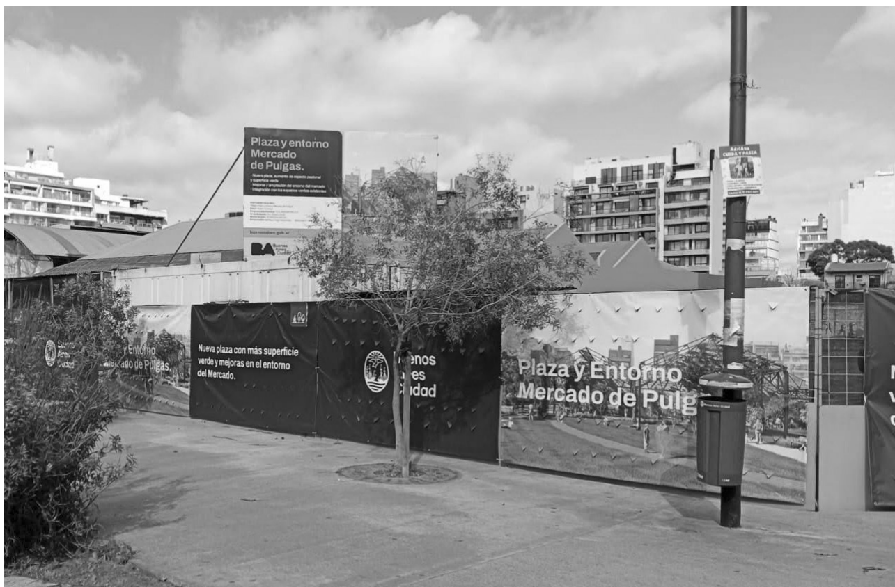
Una vista de la futura plaza desde otro ángulo: continúan construyendo el nuevo espacio verde ubicado junto al Mercado de las Pulgas. Según el cartel, oficial, 7 meses es lo que demanda la obra. En la imagen, la esquina de Martínez y Concepción Arenal.
