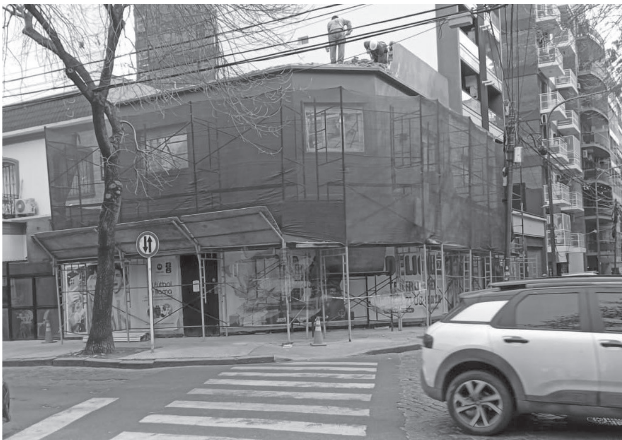
La foto tomada en Virrey Avilés y Vidal, permite comprobar la demolición de una vivienda. En la misma esquina pero en diagonal, meses atrás fue demolida otra casa y avanza rápidamente la construcción de un edificio.
