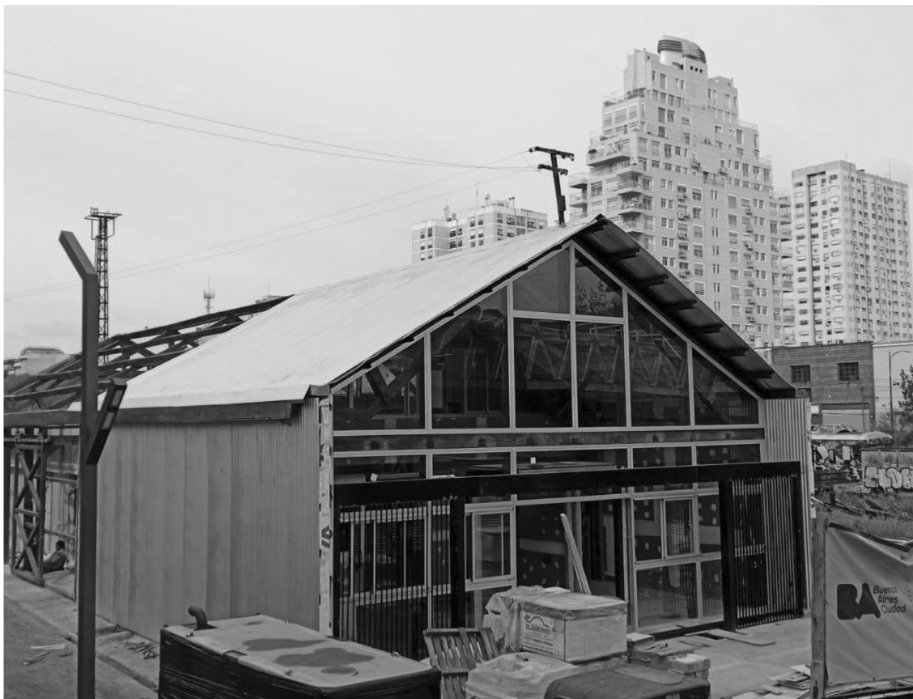
Siguen las obras en lo que será el centro de salud municipal del Parque Ferroviario de Colegiales (el único en la Comuna 13). Este es el aspecto que presentaba a fines de junio.
