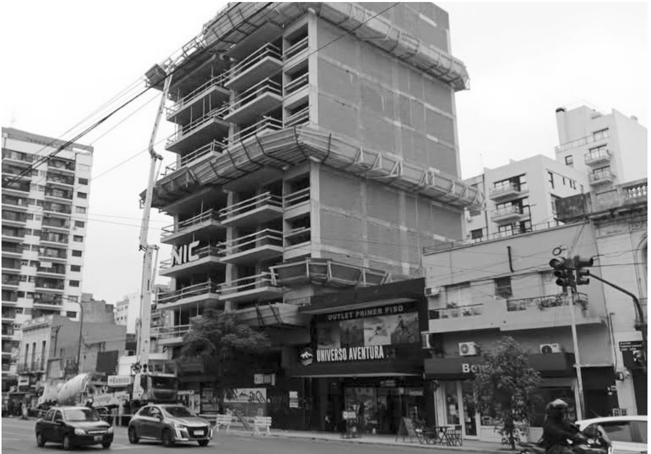
Federico Lacroze entre Ciudad de la Paz y Cabildo. En una cuadra caracterizada por la abundancia de locales comerciales, avanza la construcción de este edificio de importante altura.
