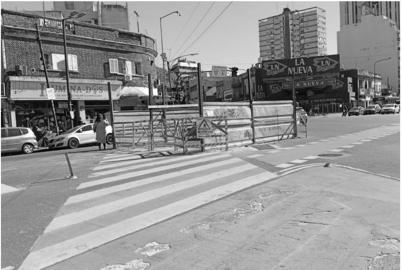
Forest y Álvarez Thomas/Elcano. En este cruce de avenidas en el cual se juntan tres barrios (Colegiales, Chacarita y Villa Ortúzar) la empresa Aysa se encontraba haciendo obras que dificultaban el paso cuando se tomó la foto.
