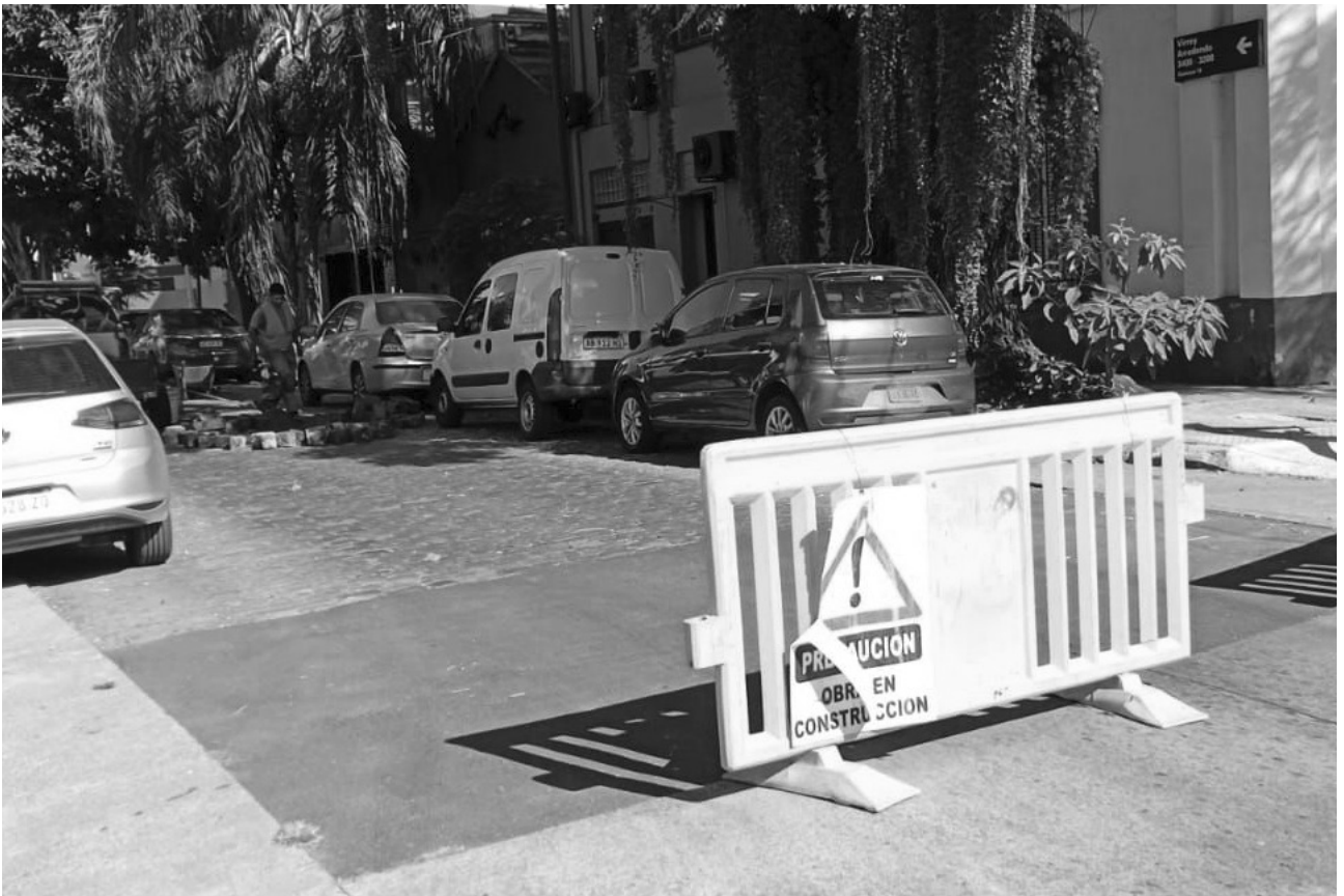
Hace unas semanas, se realizaron obras en el adoquinado de Virrey Arredondo entre Superí y Martínez. Por este motivo el tránsito vehicular estuvo interrumpido. Poco después terminaron las obras y se normalizó.
