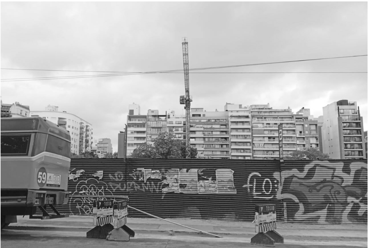
Una grúa de gran altura aparece por sobre el cerramiento de la calle Concepción Arenal, entre Freire y Zapiola. Es la muestra de que prosiguen las obras en la manzana donde hasta hace unos años funcionó el centro de exposiciones municipal El Dorrego. En el predio construirán torres y una plaza.
