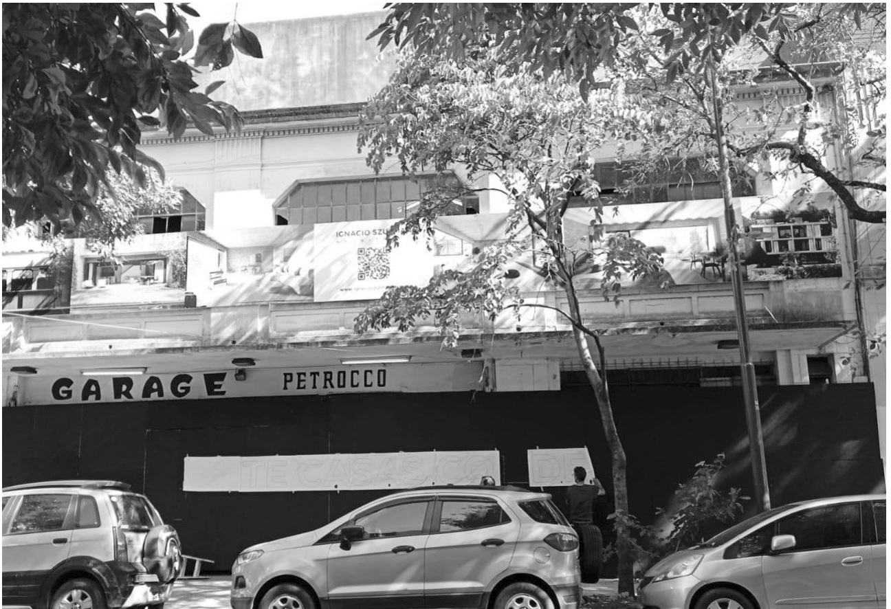
Después de algunos días transcurridos a partir de su cierre definitivo, ya se conoce el destino que tendrá el ex garage de Conde y Virrey Avilés. Los carteles que colocaron en el frente indican que habrá un edificio.
