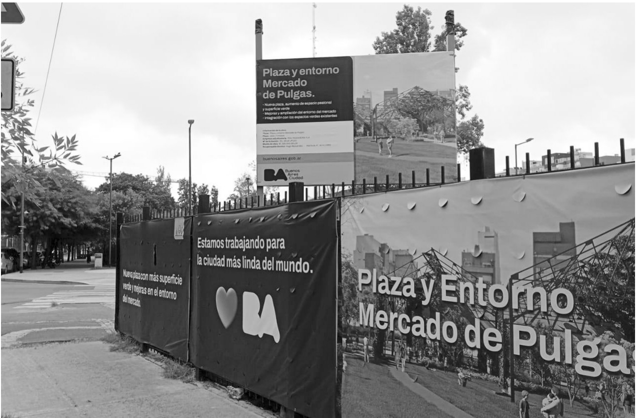
Continúa la construcción de la plaza de Concepción Arenal entre Álvarez Thomas y Enrique Martínez. Según lo que indica el cartel colocado por el Gobierno de la Ciudad que asoma por encima del enrejado pe- rimental, la obra demandará un total de siete meses.
